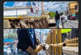
Trabajos de reparación y acondicionamiento de L... 29 de marzo a las 19:01
